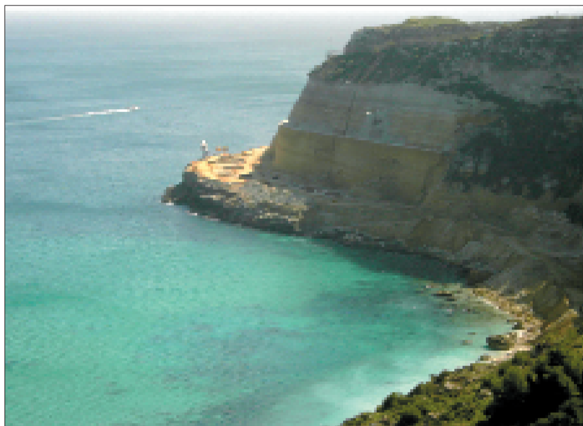
El afianzamiento de la pared del acantilado provocó meses de retraso en la construcción de la planta desalinizadora
