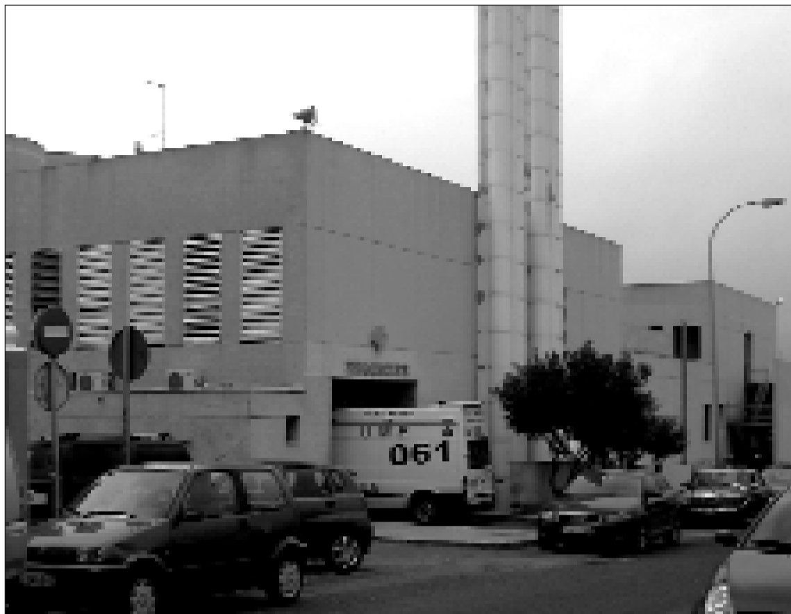
Urgencias del Hospital Comarcal, instalaciones deficientes en opinión de los profesionales y usuarios que esperan la entrada en funcionamiento del nuevo hospital
