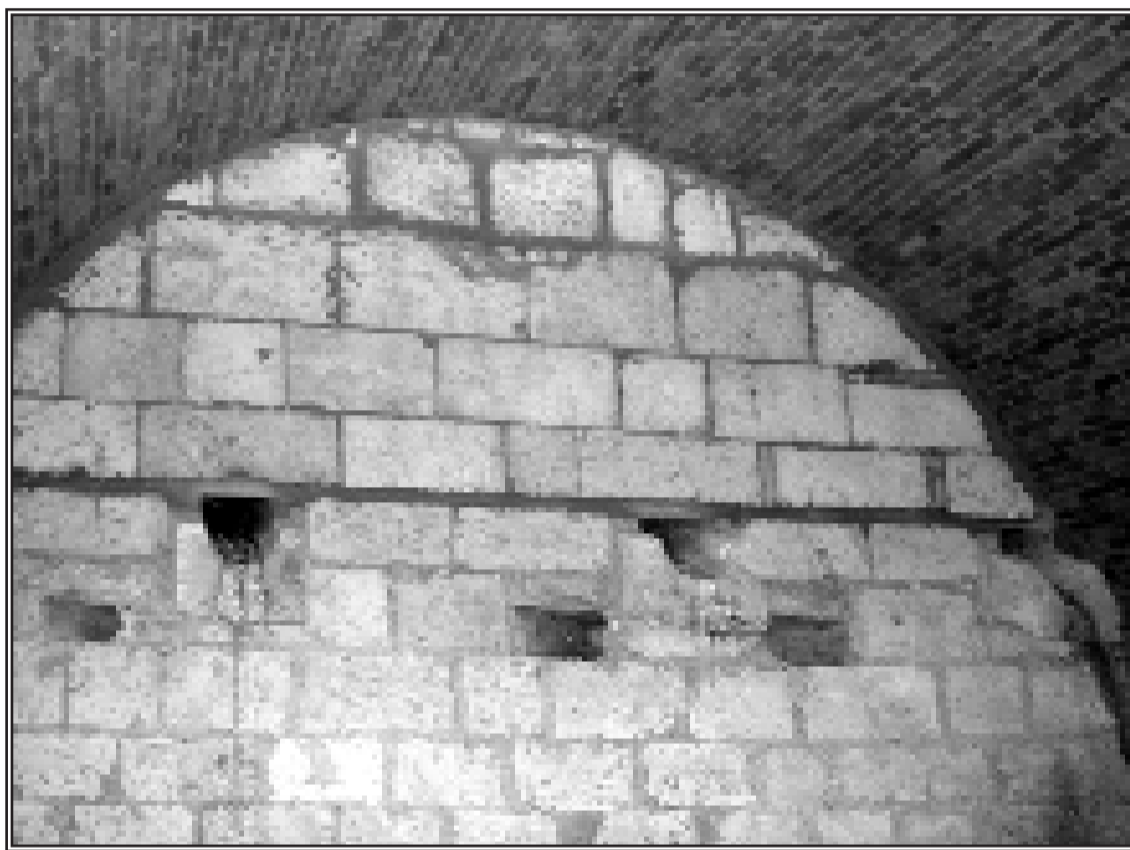
Vista de la cubierta abovedada del aljibe correspondiente a las obras de 1793, los caños que vierten el agua del decantador y la sillería propia de la obra del siglo XVI
