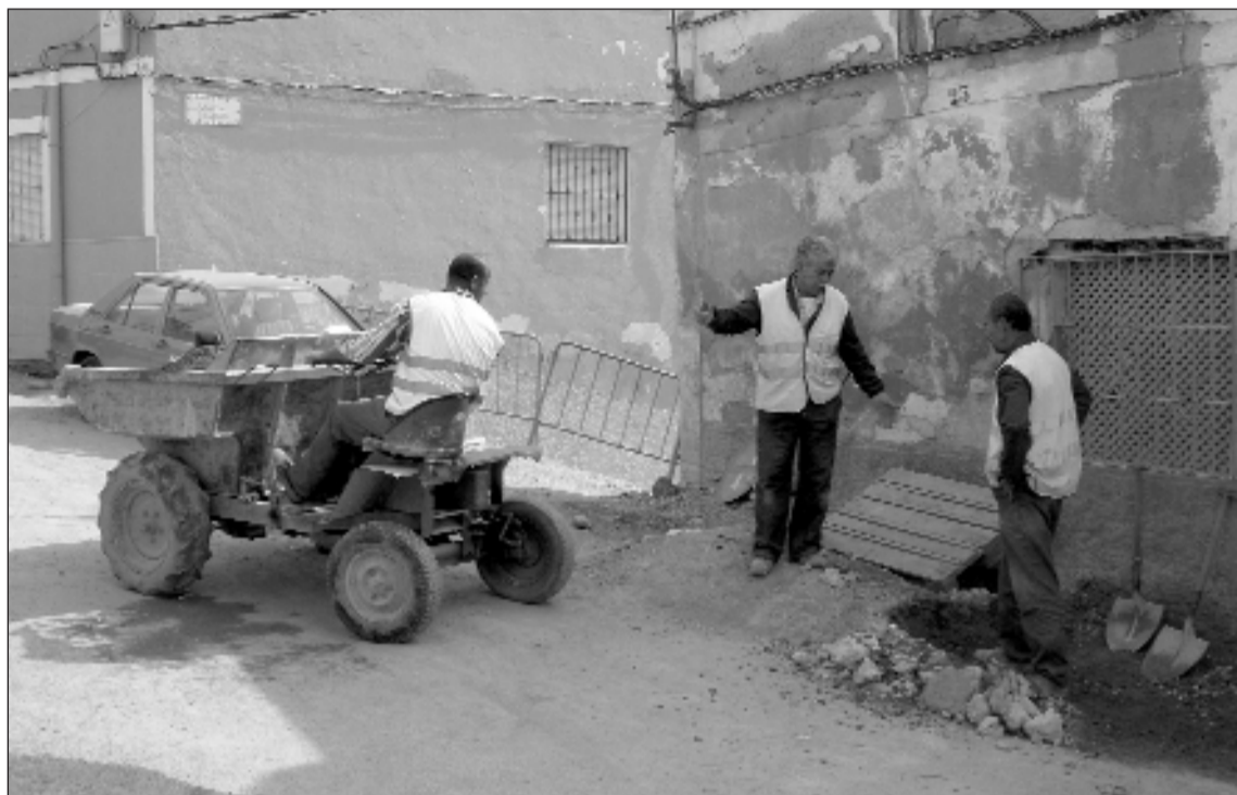
Trabajadores en una obra de renovación de infraestructuras
