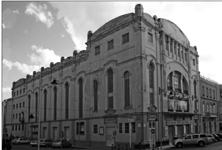
Vista lateral exterior del Cine Nacional, 2007
