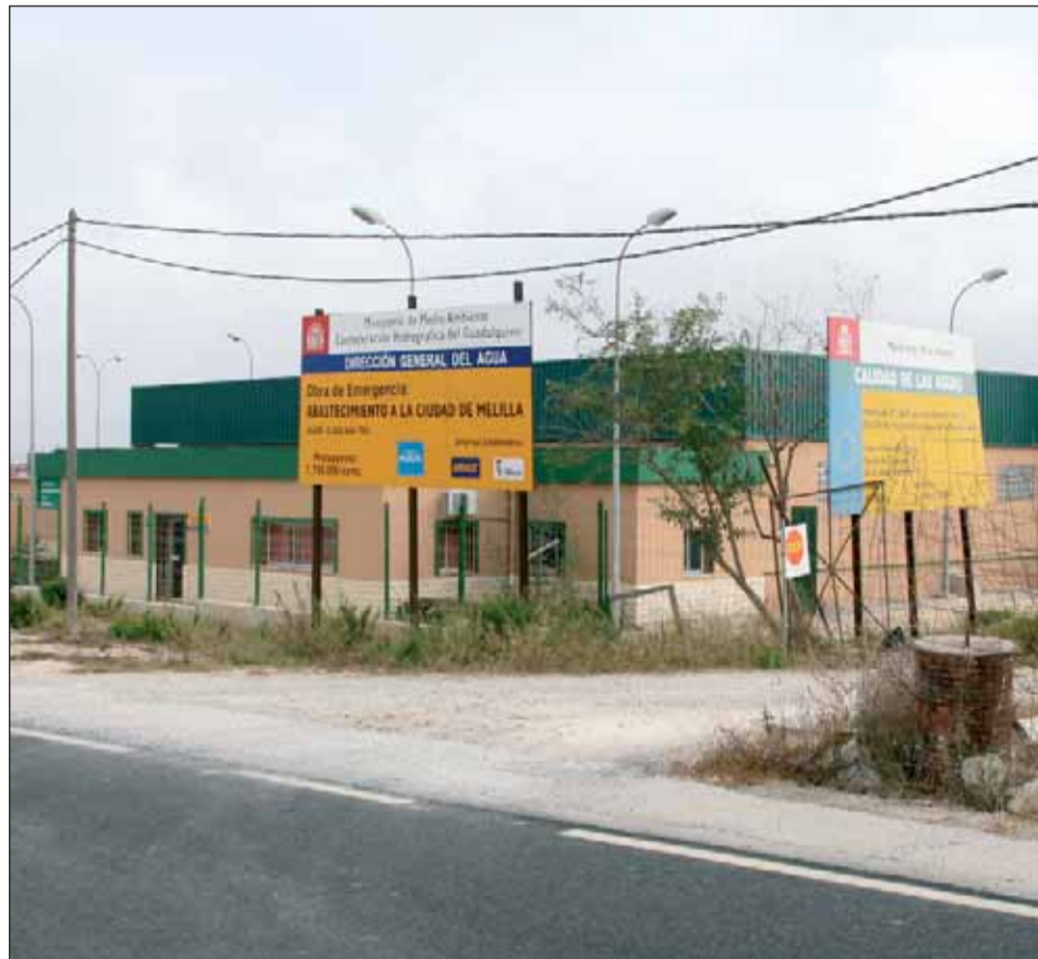
Planta potabilizadora para el abastecimiento de agua en Melilla
