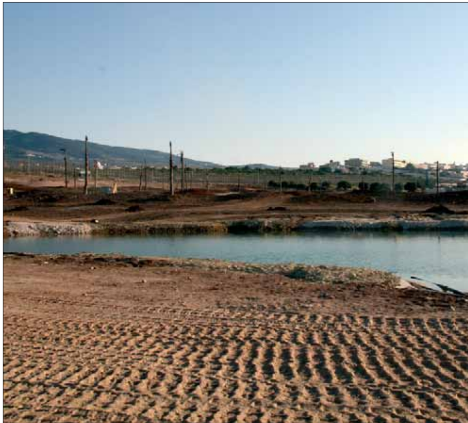
Vista del futuro campo de golf en las inmediaciones de Sidi Auariach
