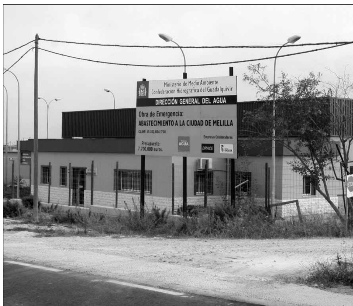
Detalle del complejo de las nuevas instalaciones de Rostrogordo dedicadas al abastecimiento del agua potable de Melilla
