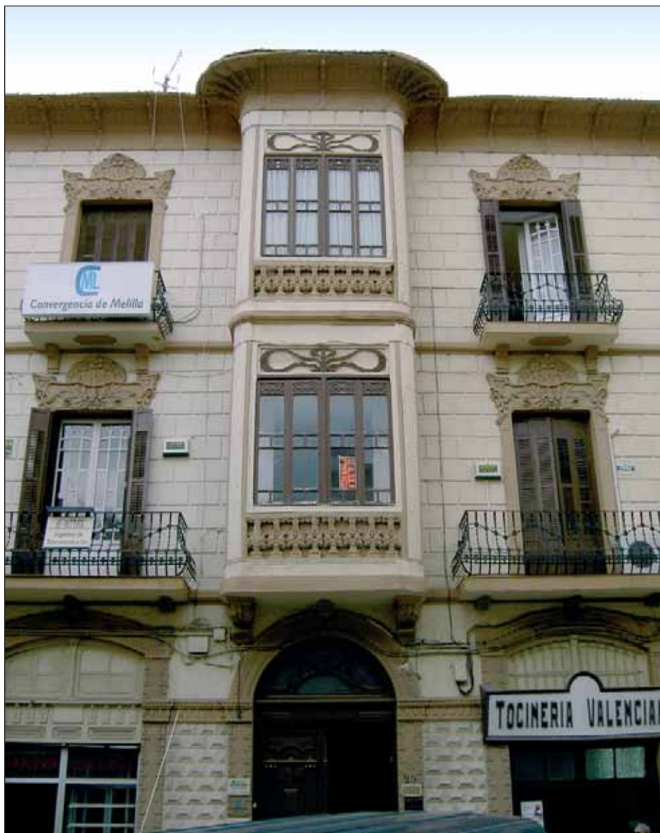
Fachada del edificio de la calle General O'Donnell, 31
